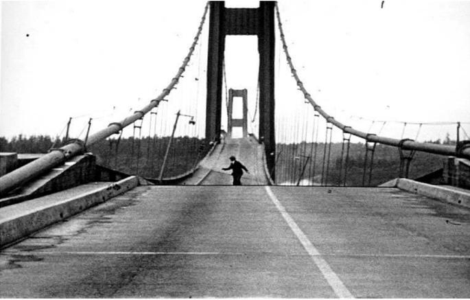
**Резо́нанс** (фр. *resonance*, от лат. *resono* — откликаюсь) — явление резкого возрастания амплитуды вынужденных колебаний, которое наступает при совпадении частоты внешнего воздействия с некоторыми значениями (резонансными частотами), определяемым свойствами системы. Увеличение амплитуды — это
